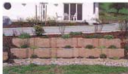
MURA: das Fertigmauersystem mit eingebauten Vegetationsinseln.
